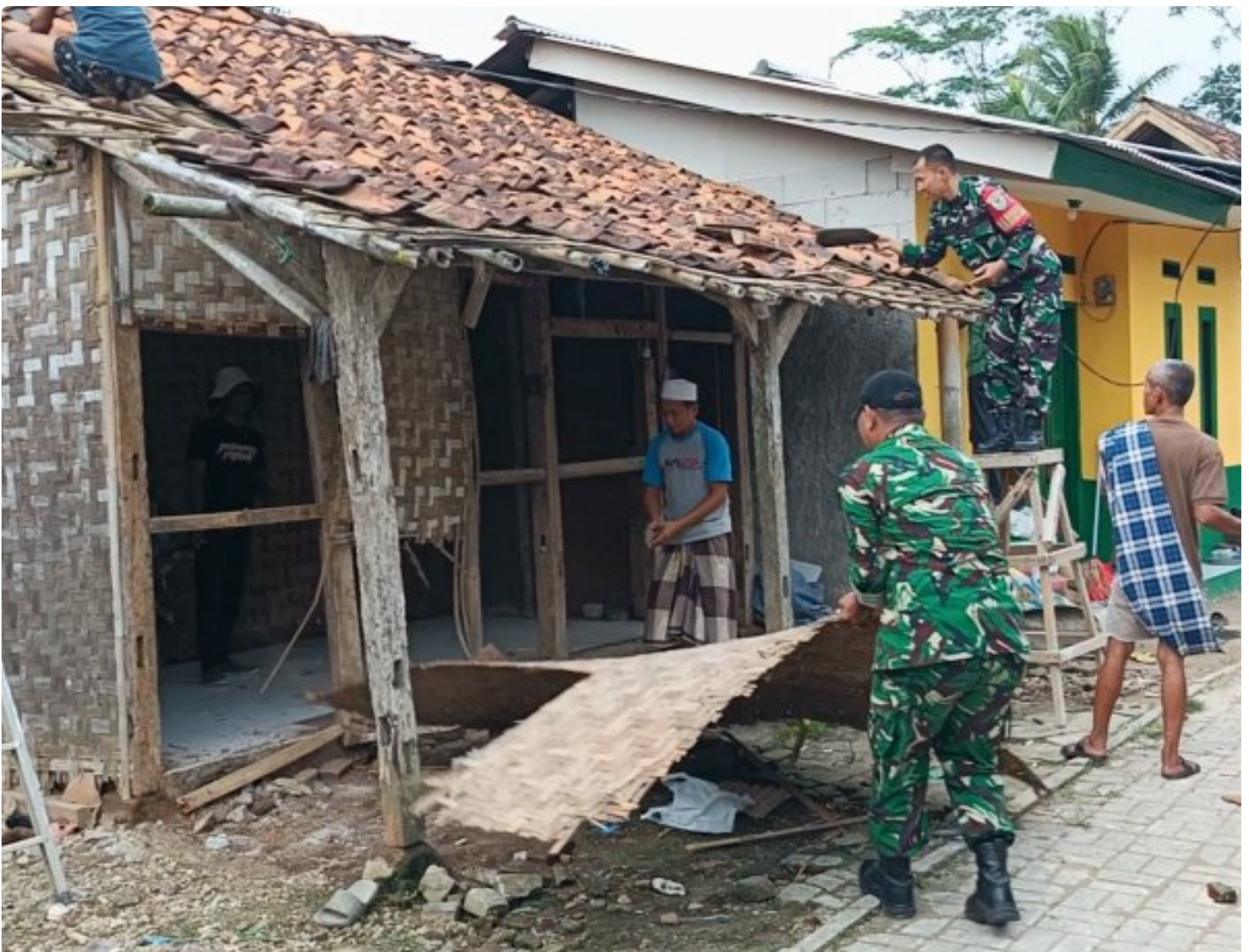
Pembongkaran Rumah Bapak Narmin
